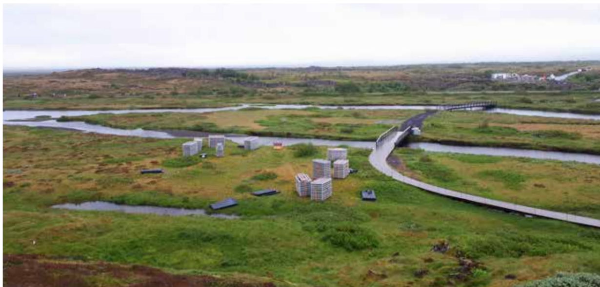
Mynd 4. Við upphaf uppsetningar þingpalla.
