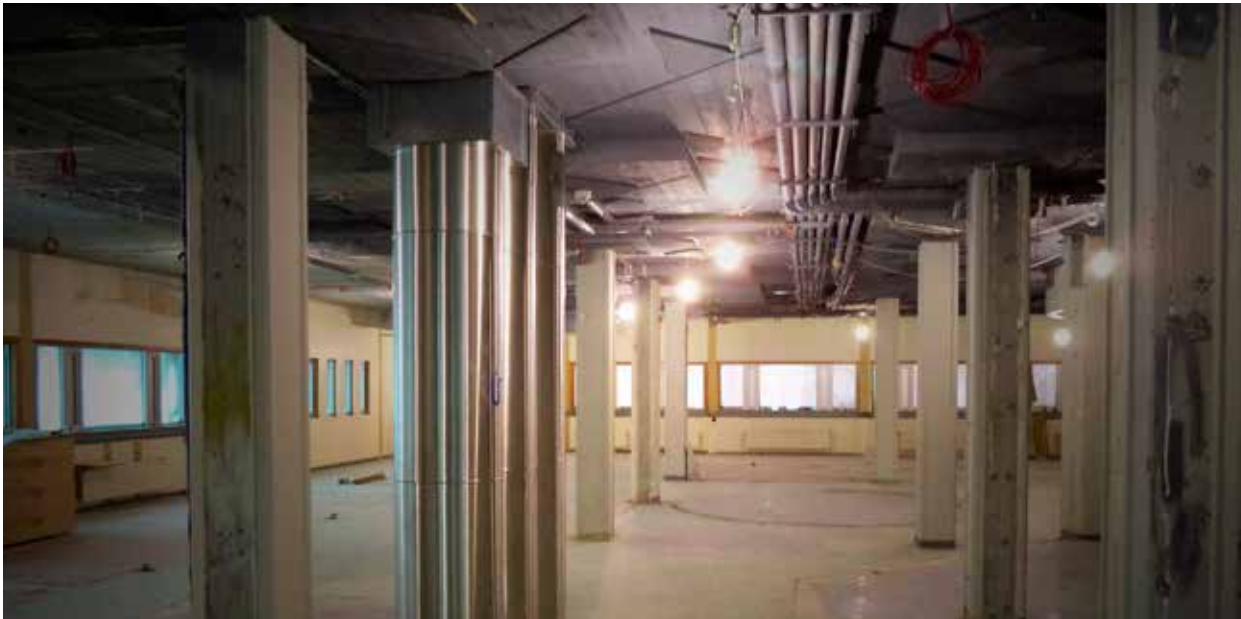
Mynd 2. Unnið við einangrun útveggja.
