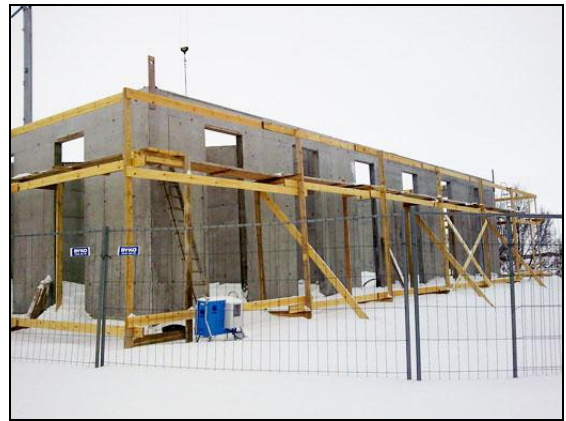
Skjólvangur 2 á Egilsstöðum í byggingu.
