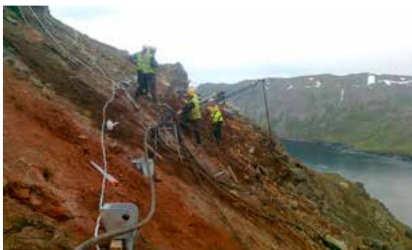
Mynd 5. Borun fyrir festibolta.
