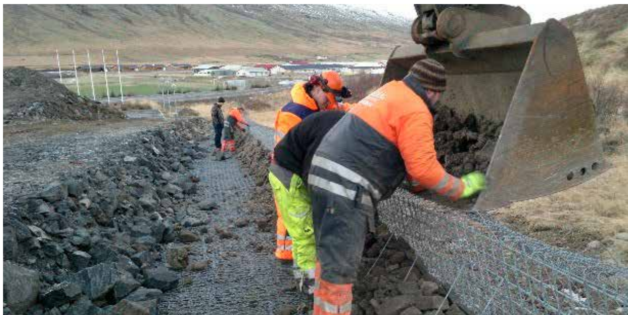
Mynd 6. Grjóti handraðað í styrkinguna.
