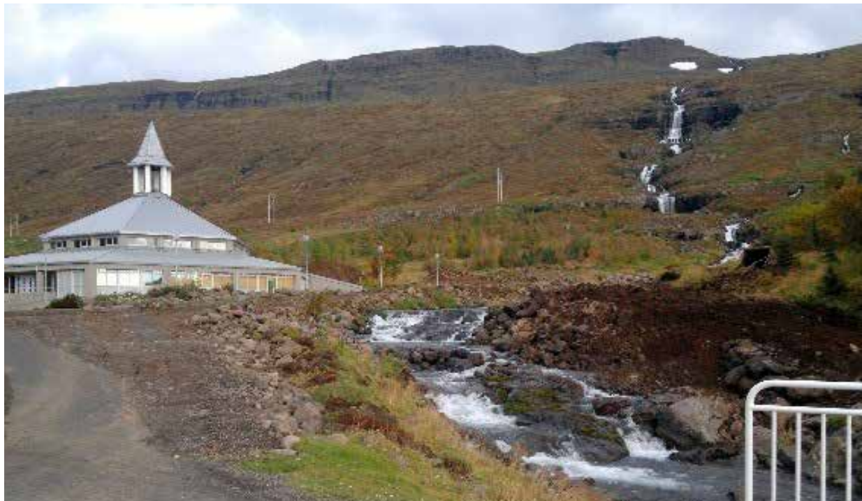
Mynd 1. Í upphafi framkvæmda.
