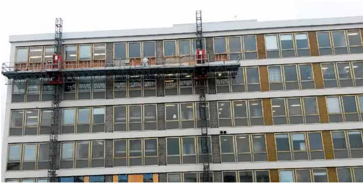
Mynd 2. Í upphafi framkvæmda á norðurhlið.
