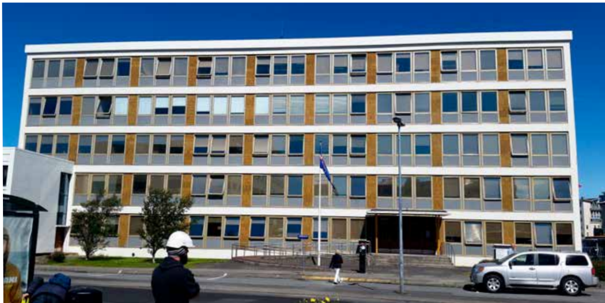
Mynd 1. Útlit framhliðar fyrir framkvæmdir.
