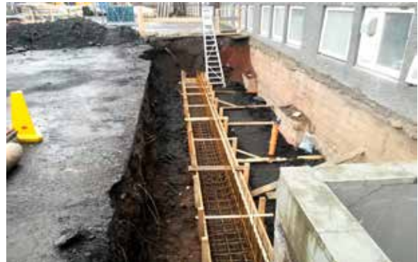
Mynd 7. Unnið að gerð undirstöðu undir stoðvegg.
