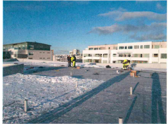
Mynd 1. Unnið við að díla dúk á þaki húss.
