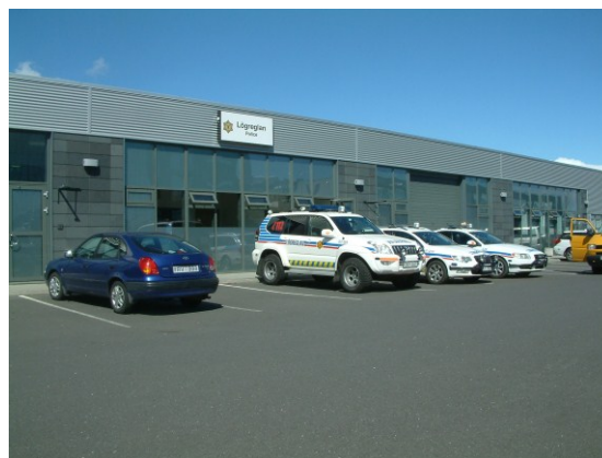
Mynd 1: Lögreglustöð 4, Vínlandsleið
