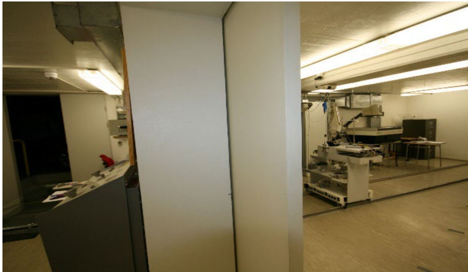
Mynd 3. Þykkir veggir (40 cm) og blýklædd hurð (4 mm) á milli stjórnherbergis og mælirýmis.
