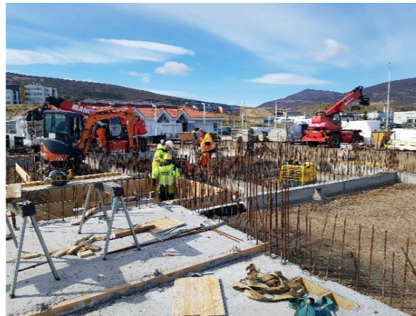
Mynd 3. Unnið við byggingu sókkla.
