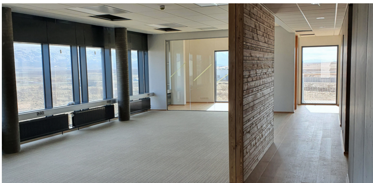
Mynd 6. Framkvæmdir innanhúss.
